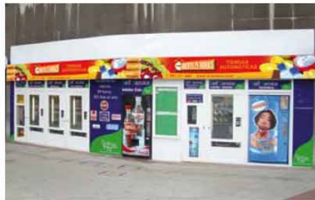
Obra de tienda 25 horas antes y después. San Mames - Bilbao
